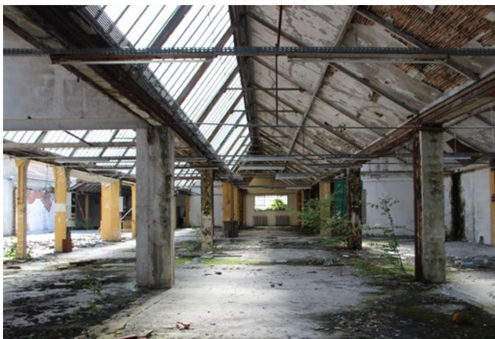
Site Loisin, Montceau-les-Mines © Ville de Montceau-les-Mines
