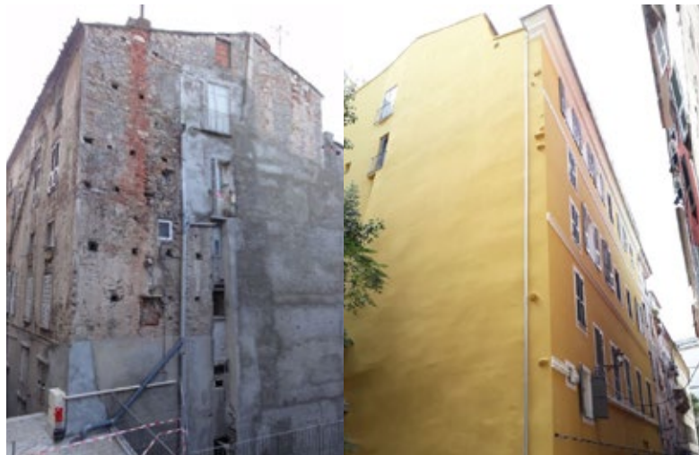
Façades des 12-14 rue Chanoine Letteron avant et après travaux (© ville de Bastia)
