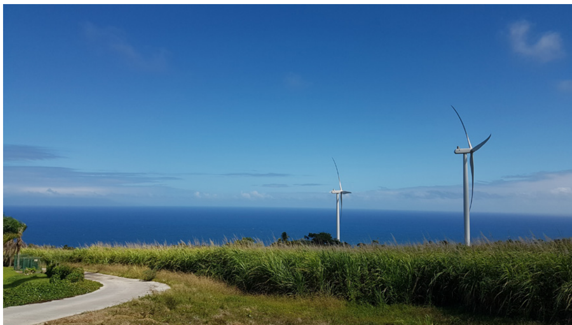
Le parc éolien de Grand-Rivière © Ademe
