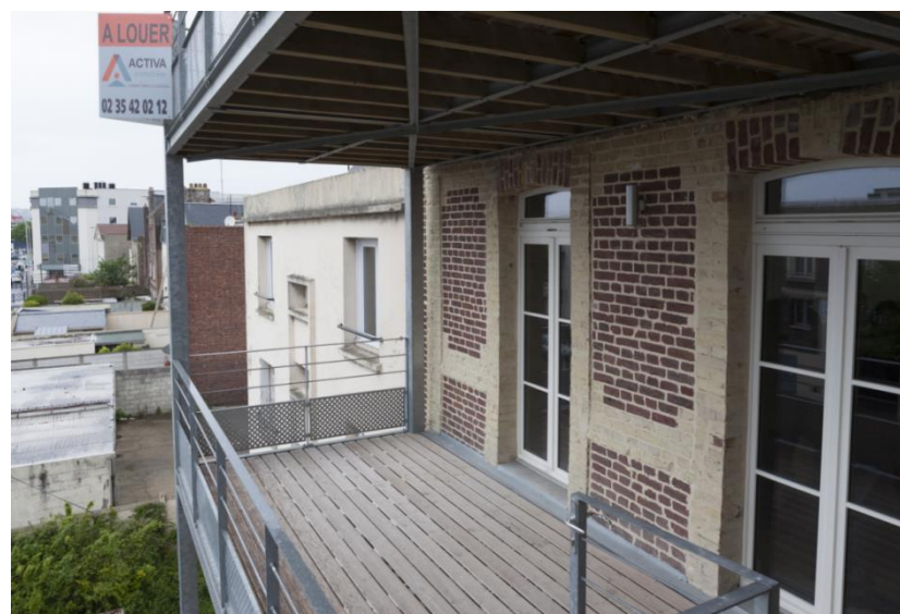
Balcon d'un bâtiment rénové au Havre – Anah/ Stephan Norsic
