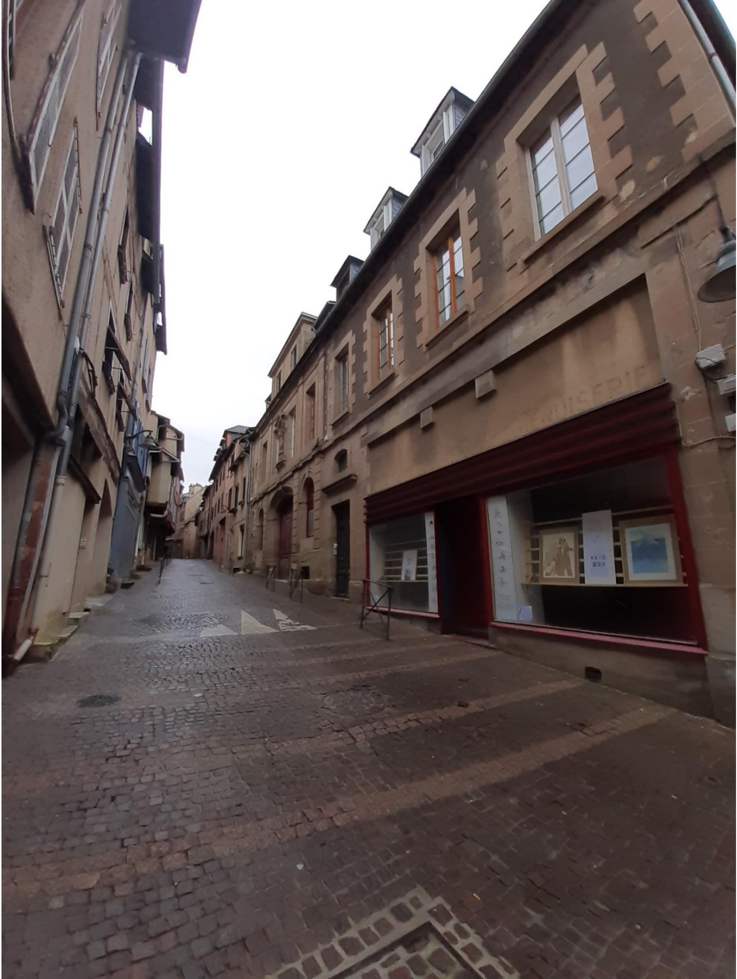
bâtiments en pierre de taille et pierre enduite au mortier de chaux (fin XIXème siècle)
