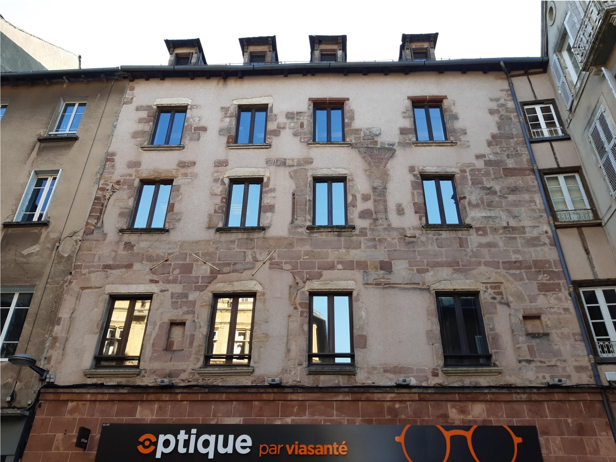
Cette façade est un condensé d’histoire architecturale de Rodez : palais gothique (vers 1270), éléments d’architecture renaissance, du XVIIIème siècle et d’aujourd’hui. On note les différents traitements de maçonnerie : pierre de taille et maçonnerie de pierre enduite
