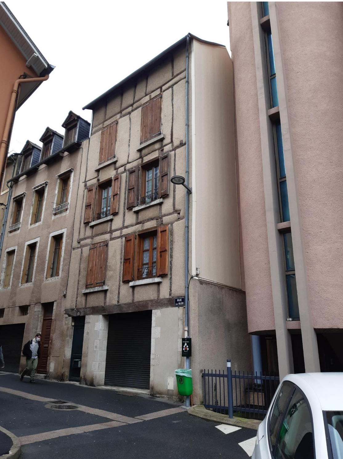
Rodez rue de la Bullière (chantier de 2013) : ITE réalisée en panneaux « Myral » de chez Uniso (bardage métallique « imitation » enduit, avec 50 mm de mousse de polyuréthane) : manque de respirabilité (« effet Tupperware ») et aspect extérieur très contestable
