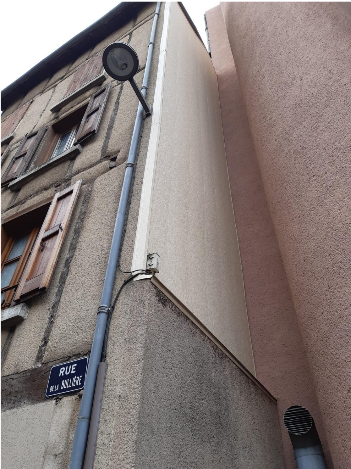
Rodez rue de la Bullière (chantier de 2013) : ITE réalisée en panneaux « Myral » de chez Uniso (bardage métallique « imitation » enduit, avec 50 mm de mousse de polyuréthane) : manque de respirabilité (« effet Tupperware ») et aspect extérieur très contestable
