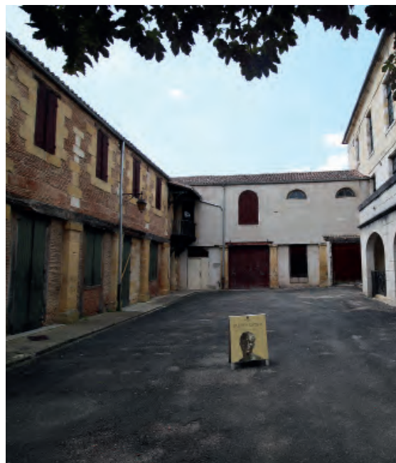
Une vue de la cour avant les travaux
