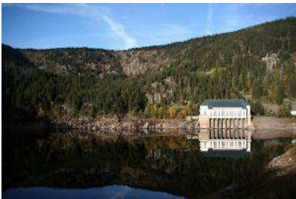
L'ancienne centrale du Lac noir avant 2002.
