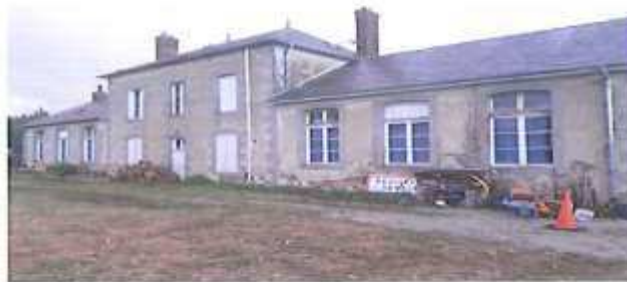
6 fenêtres arrières de deux classes école (à gauche et droite du bâtiment logement)
