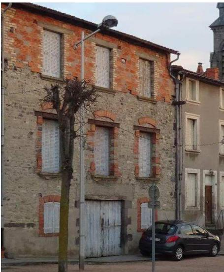
*Arc de décharge en briques au-dessus des linteaux en bois et jambages en pierres, Maringues*
