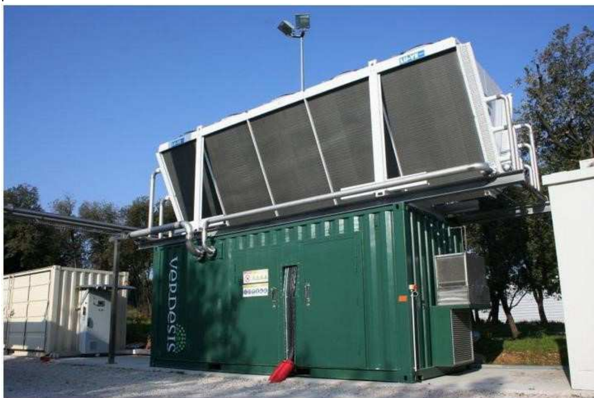
Figure 42 : Turbine ORC sur le site Delta déchets à Orange exploitée par DALKIA BIOGAZ (source : https://www.dalkiabiogaz.com/cogeneration-production-delectricite-et-de-chaleur )
